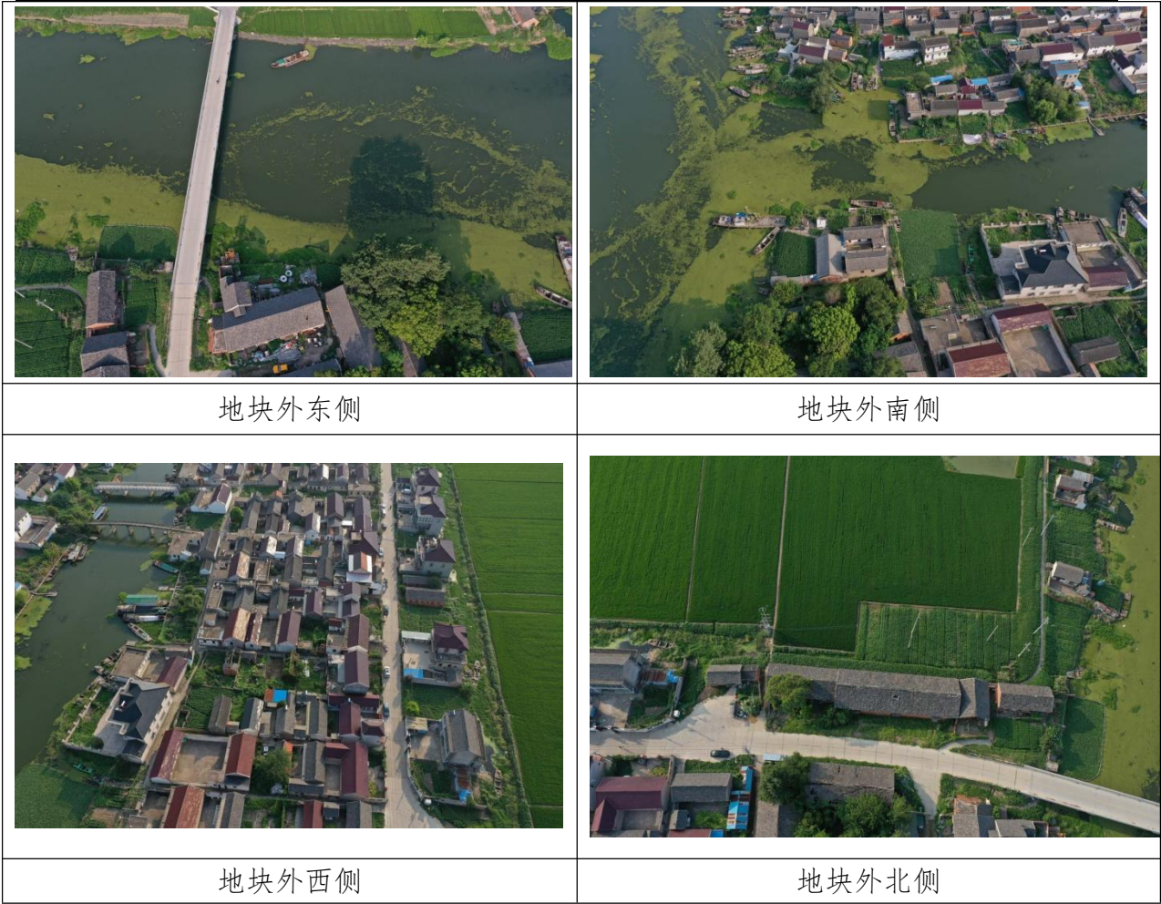
图 3.9 现场踏勘情况
