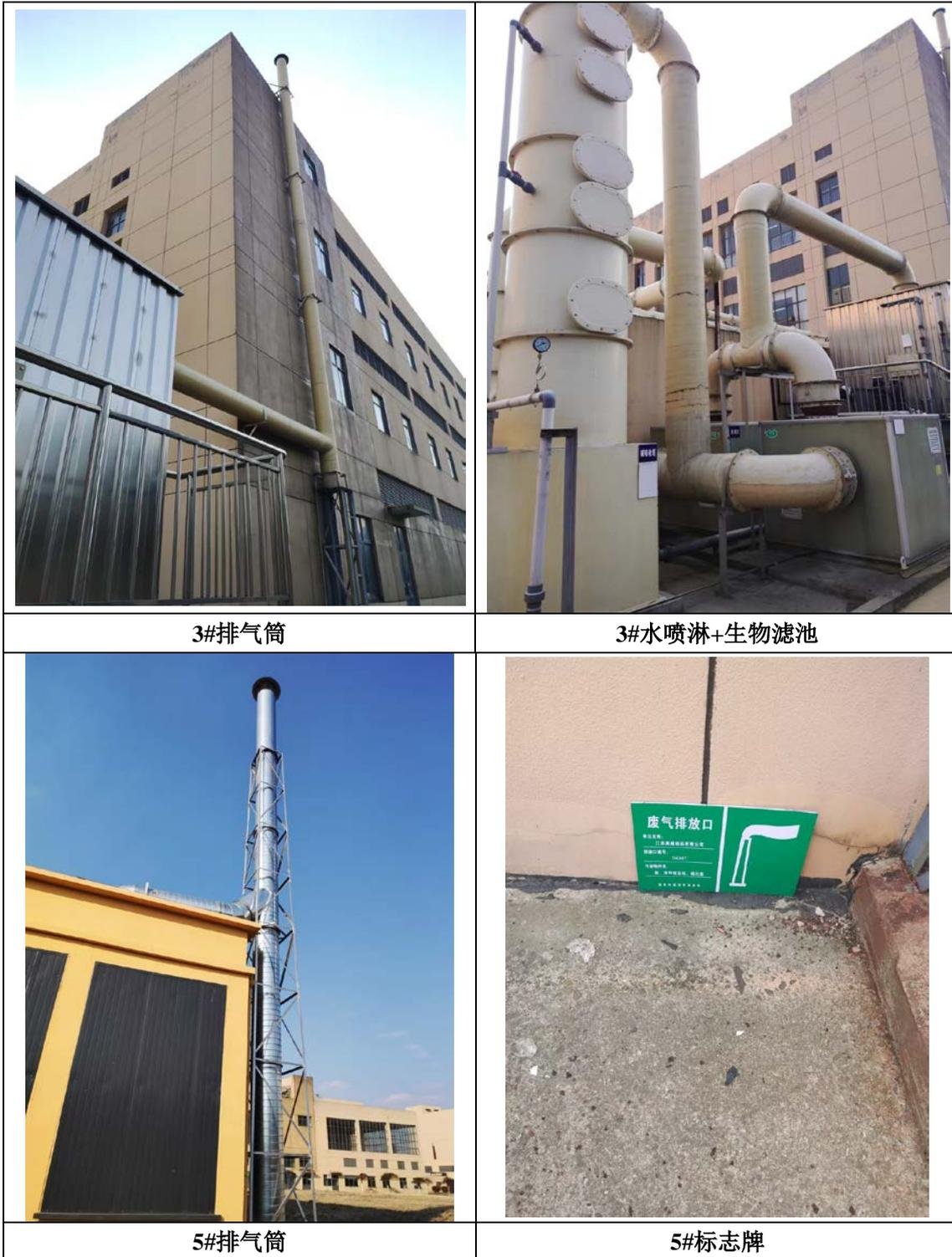
图 4.1-2 废气处理设施及排气筒设置图
